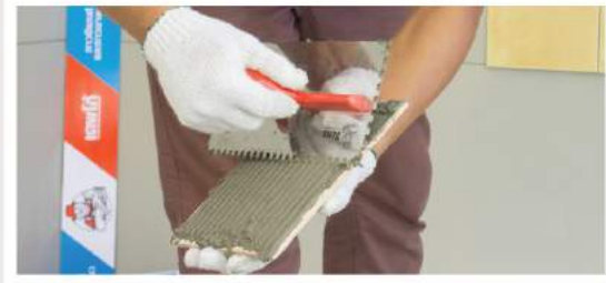
2. ปาดกาวซีเมนต์ลงบนหลังกระเบื้อง
