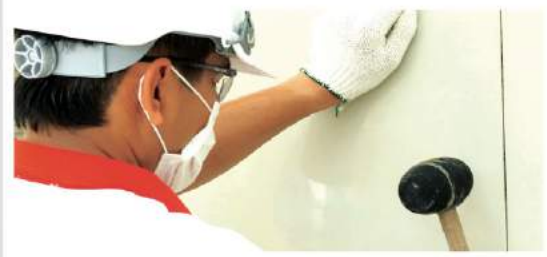
4. ปูกระเบื้องบนผนัง ใช้ค้อนยางเคาะให้ทั่ว
