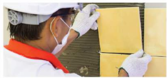
3. วางติดทับลงบนกระเบื้องเดิม
