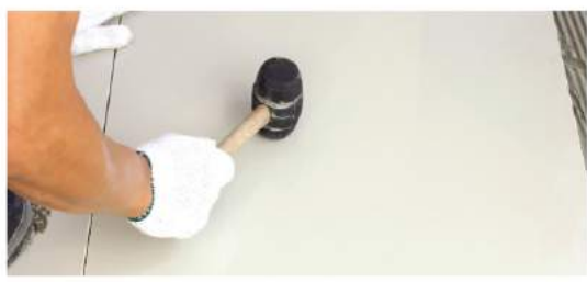
4. ปูกระเบื้องบนพื้น ใช้ค้อนยางเคาะให้ทั่ว
