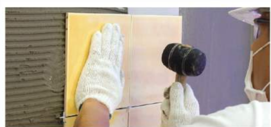
5. ปูกระเบื้องทับกระเบื้องเดิม ใช้ค้อนยางเคาะให้ทั่ว
