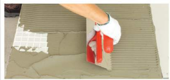
2. ปาดกาวยาซีเมนต์ลงบนหลังกระเบื้อง
