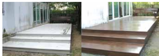
ก่อนการติดตั้ง
