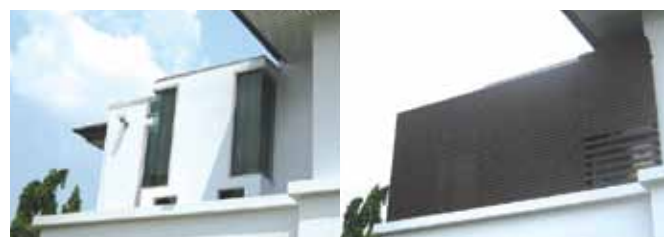
ก่อนการติดตั้ง
