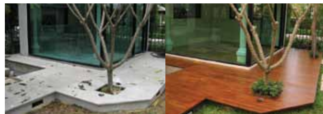
ก่อนการติดตั้ง
